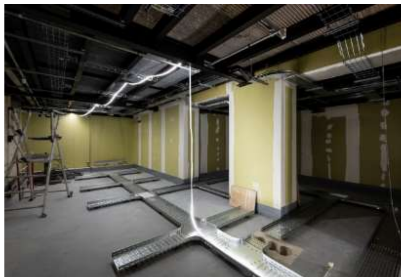
Fin de curage et dépollution (septembre 2023)
