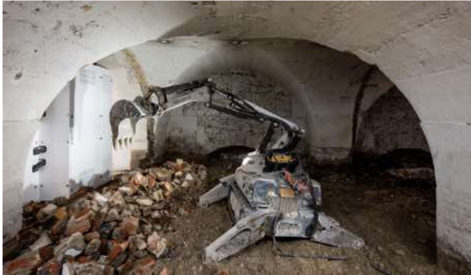
Démolition et terrassement au sous-sol, zone PP (mars 2024)
